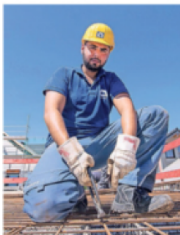
Ein Azubi auf einer Baustelle. FOTO: DPA
