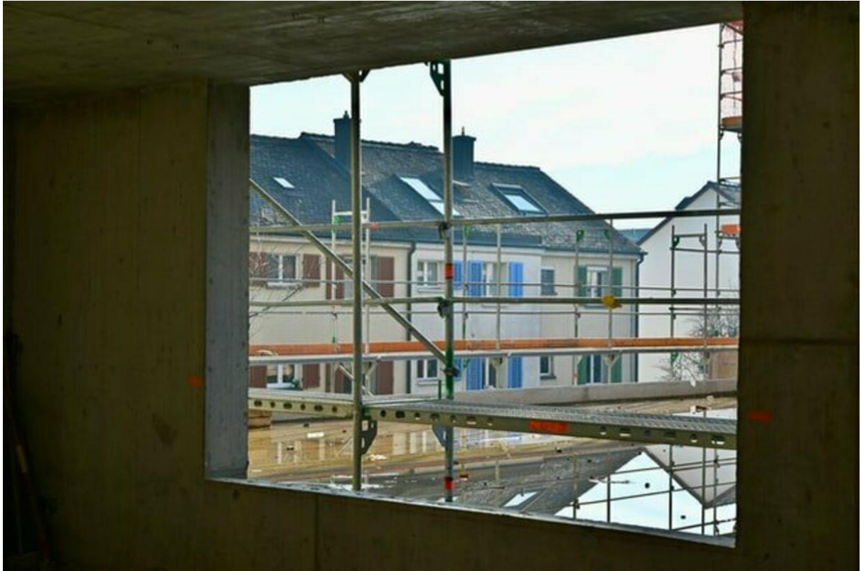
Foto: IG BAU
