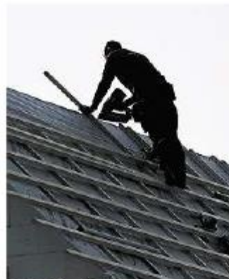
Dachdecker bekommen jetzt einen Inflationsausgleich. FOTO: JAN WOITAS
